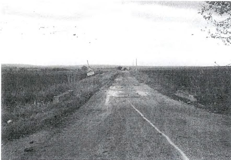
Foto 2. Tratto iniziale della Strada Vicinale *Serracapriola-Apricena*, a partire dalla S.S. 16, indicata nella TAV. 8 del progetto come strada di accesso da impiegare per la realizzazione dell'impianto eolico. Questa strada non risulta idonea al transito di mezzi di Trasporto Eccezionale della portata di quelli previsti per la realizzazione dell'impianto eolico di progetto.
