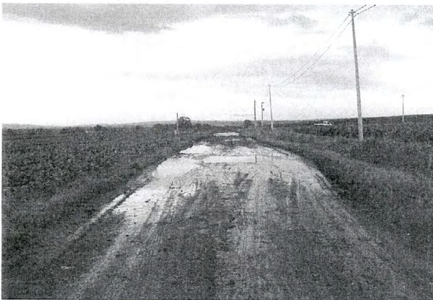
Foto 3. Tratto intermedio della Strada Vicinale *Serracapriola-Apricena*. E' evidente lo stato di precarietà della strada, del tutto inadatta al transito di mezzi di Trasporto Eccezionale della portata di quelli previsti per la realizzazione dell'impianto eolico di progetto.
