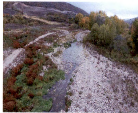
Lavori di arginatura sul T. Cervaro (CA_CE01). Ripresa della vegetazione spontanea dopo abbattimento della fascia perifluviale - 14 novembre 2017
