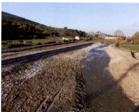
Lavori di arginatura sul T. Cervaro (CA_CE01) - 28 marzo 2017
