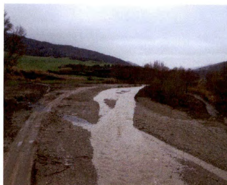
Lavori di arginatura sul T. Cervaro (CA_CE01) - 6 marzo 2017
