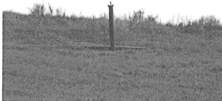
Foto 4.1 - Camino di aspirazione del biogas
