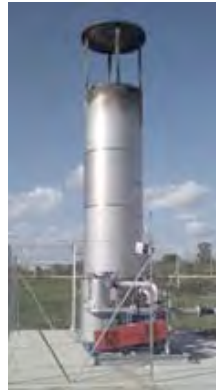
Torcia statica di combustione biogas con piedistallo (a sx) e torcia dinamica da 500 Nmc/h (a dx)
