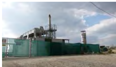
Torcia statica di combustione biogas con piedistallo (a sx) e torcia dinamica da 500 Nmc/h (a dx)
