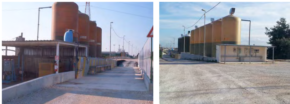
Silos di stoccaggio temporaneo percolato I Lotto (a sx) e II Lotto (a dx)
