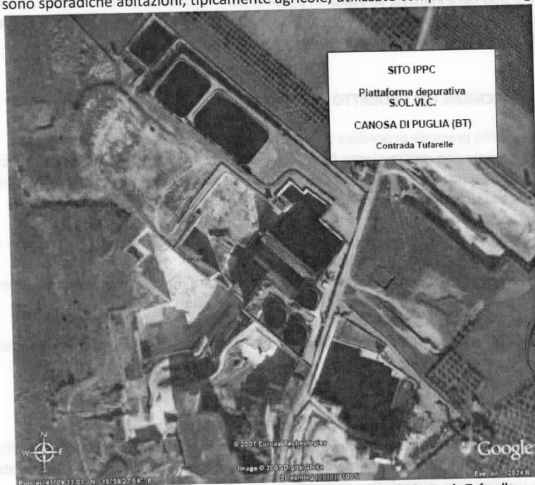
Figura 2 Inquadramento su ortofoto del complesso depurativo in Contrada Tufarelle
